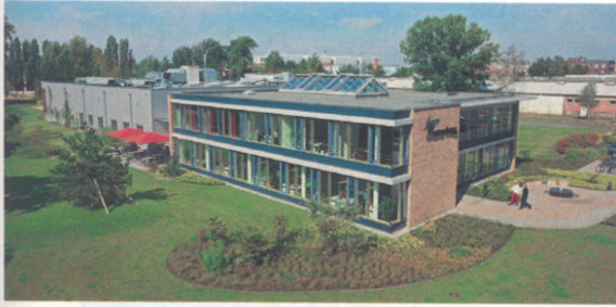
Luftbild des Firmengebäudes in Berlin
